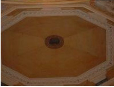
interno cupola ottagonale del vestibolo
