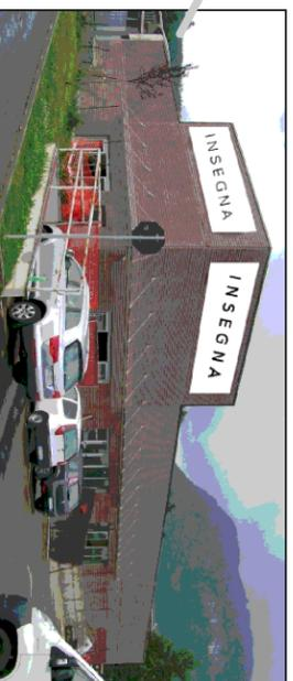
Il corpo di fabbrica sul lotto 2, ad esclusivo uso commerciale e terziario, sarà realizzato in elementi prefabbricati di buon livello per rappresentare degnamente le nuove attività che si insedieranno. A titolo di esempio si ipotizzano le facciate con inserimento di elementi pregiati tipo mattoni, piastrelle lavati, ovvero con inserti dogati in legno o metallici, oltre che serramenti in alluminio anodizzato scuro.
